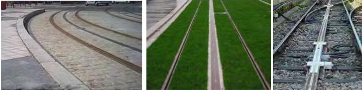
Figure : différents types de pose du profilé APS
